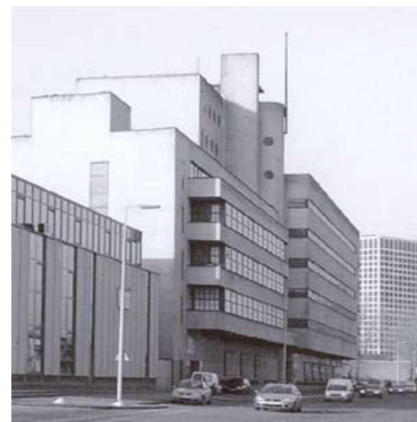
HAKA-pand, Marconiplein, Vierhavenstraat
