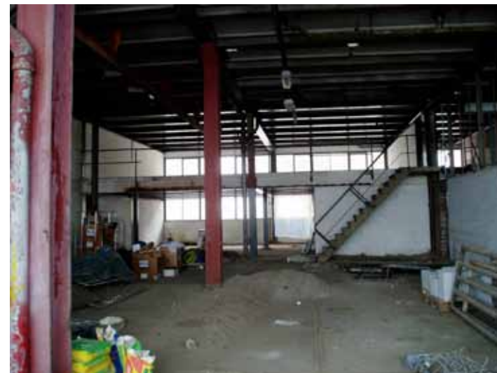
Begane grond richting entresol, oude situatie.
