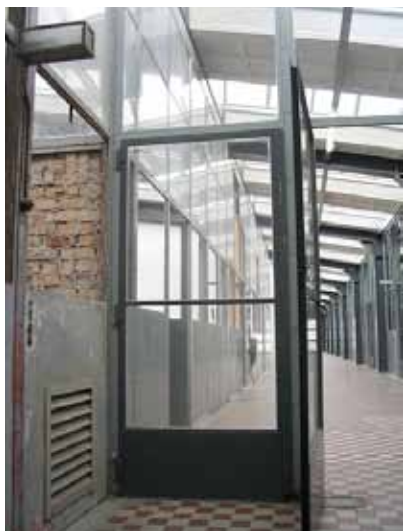
Ingang verdieping, links de voormalige kantine, oude situatie.
