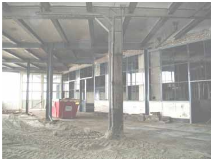
Begane grond richting uitgang, werkplaats en kabelgat, oude situatie.
