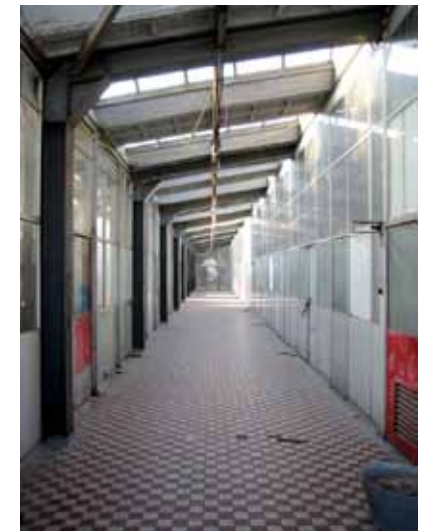
Gang op de verdieping, rechts de voormalige kantine, oude situatie.
